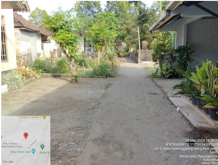
Foto Sebelum Pembangunan Jalan Paving
