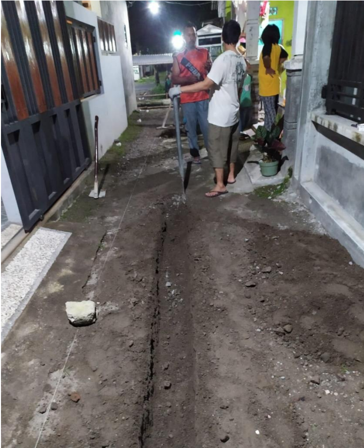
Foto Sebelum Pembangunan Saluran Drainase di tengah Jalan Paving
