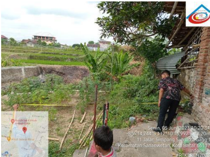
Foto Sebelum Pembangunan Balai RT 01 RW 08
